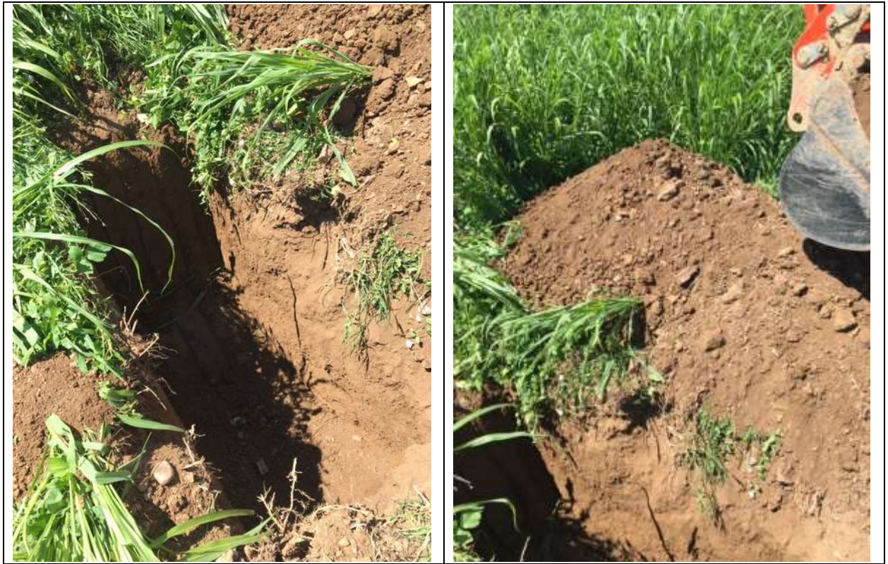
Figura 3 – Trincee di scavo – particolare dei riporti
