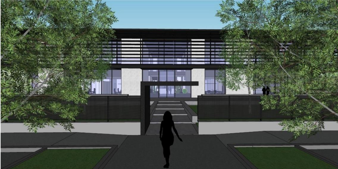
Alternate ai setti murari si ritrovano una serie di ampie vetrate allineate tra piano terra e piano primo ma interrotte dalla fascia marcapiano. Anche le vetrate si pongono in contrapposizione all'orizzontalità dell'edificio grazie i moduli verticali dei vetri dato dal passo montanti delle stesse.
