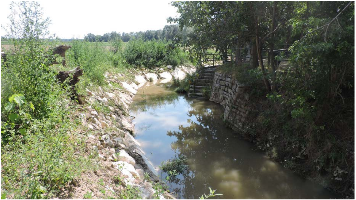
La scogliera in pietrame ciclopico, da rinverdire mediante posa di talee di salice arbustivo
