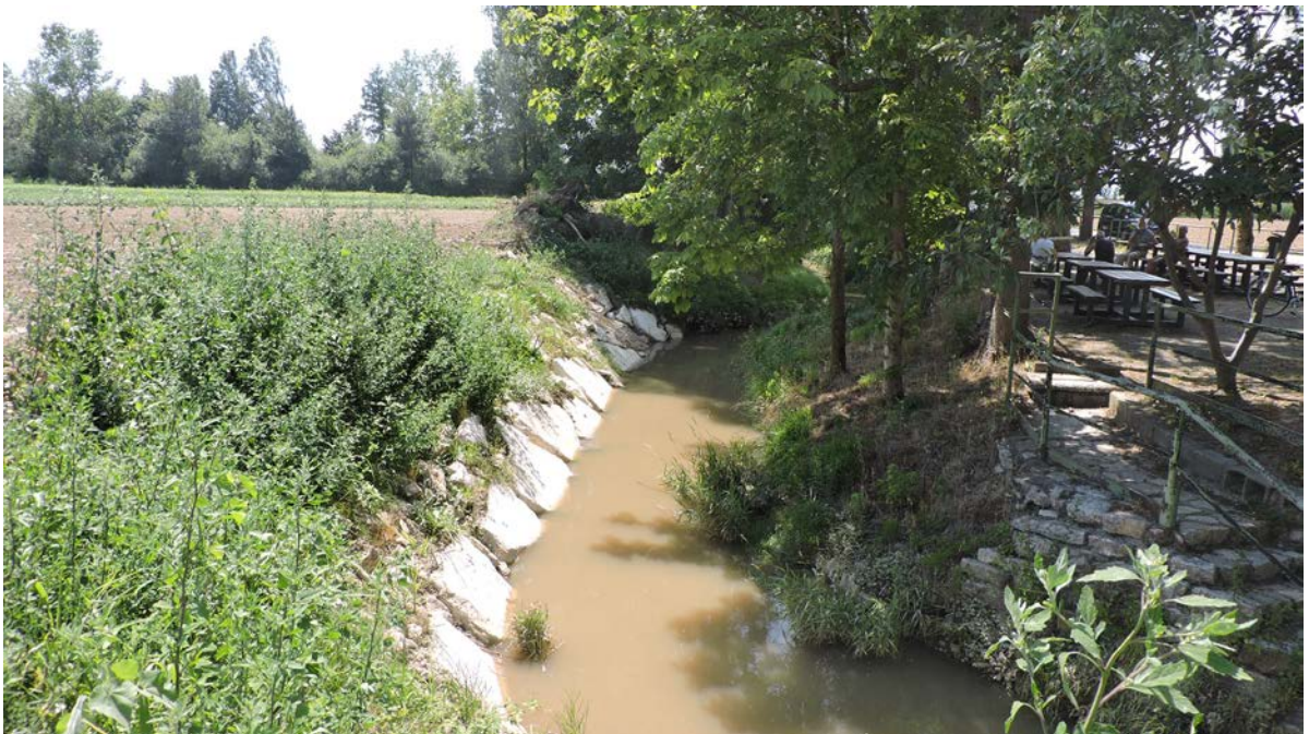
La scogliera in pietrame ciclopico, da rinverdire mediante posa di talee di salice arbustivo. Sulla sommità della sponda è prevista una piantumazione arborea autoctona con specie di acero campestre e bagolaro
